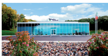
USA - Sede produttiva e commerciale che si estende in 1.500 mq.
